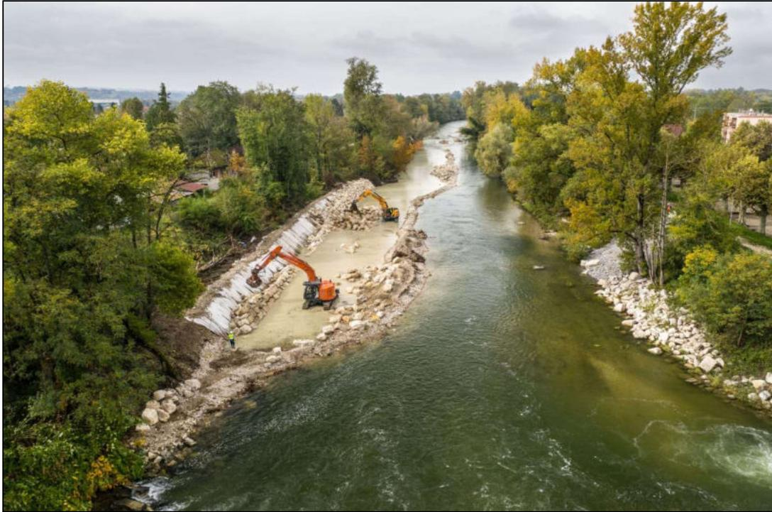
*Figure 22 : Travaux de consolidation par enrochement Digue des Autrichiens*
