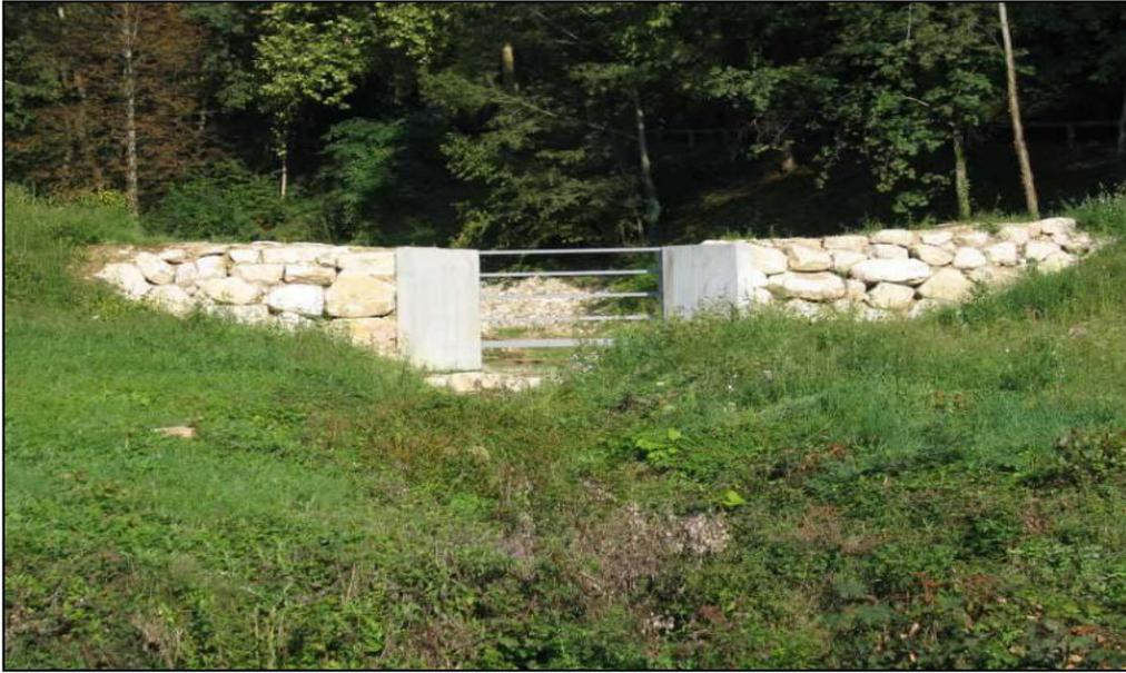
Figure 4 : photo d'une plage de dépôt Saint Geoire en Valdaine ; ruisseau du Versous
