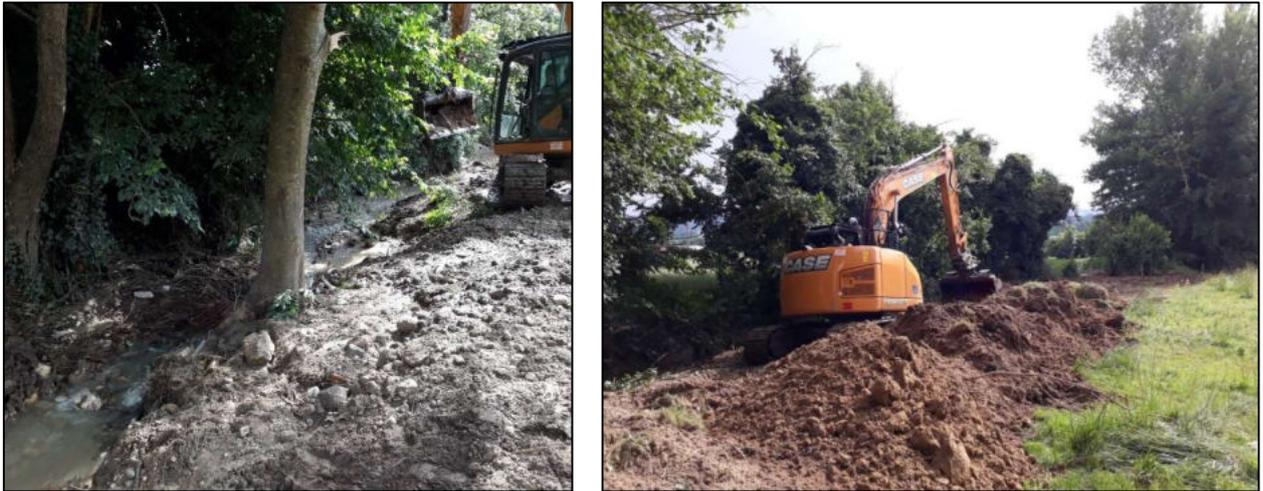
Figure 7 : photo des travaux de curage sur le ruisseau de la combe Gilly
