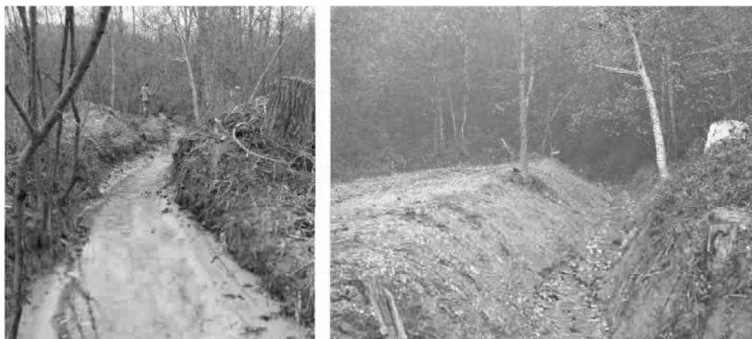
Photos de la plage de dépôt des Terpends, avant (gauche) et après (droite) curage
